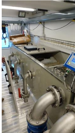
Figur 2: Iltningskammer
